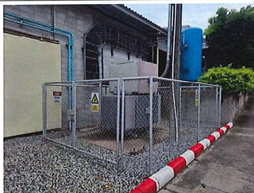
ภาพถ่ายที่ 19 ป้ายเตือนบริเวณหม้อแปลงไฟฟ้า
