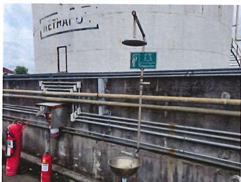
ภาพที่ 29 อ่างล้างตาและร่างกายฉุกเฉิน
