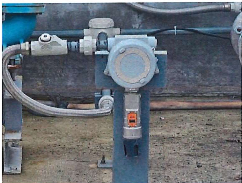
ภาพที่ 1 Gas detector ที่บริเวณถังเก็บสารเมทานอล
