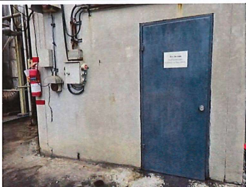
ภาพที่ 3 ผนังควบคุมเสียงจากเครื่องกำเนิดเสียง
